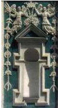
Фрагмент її ліплення
